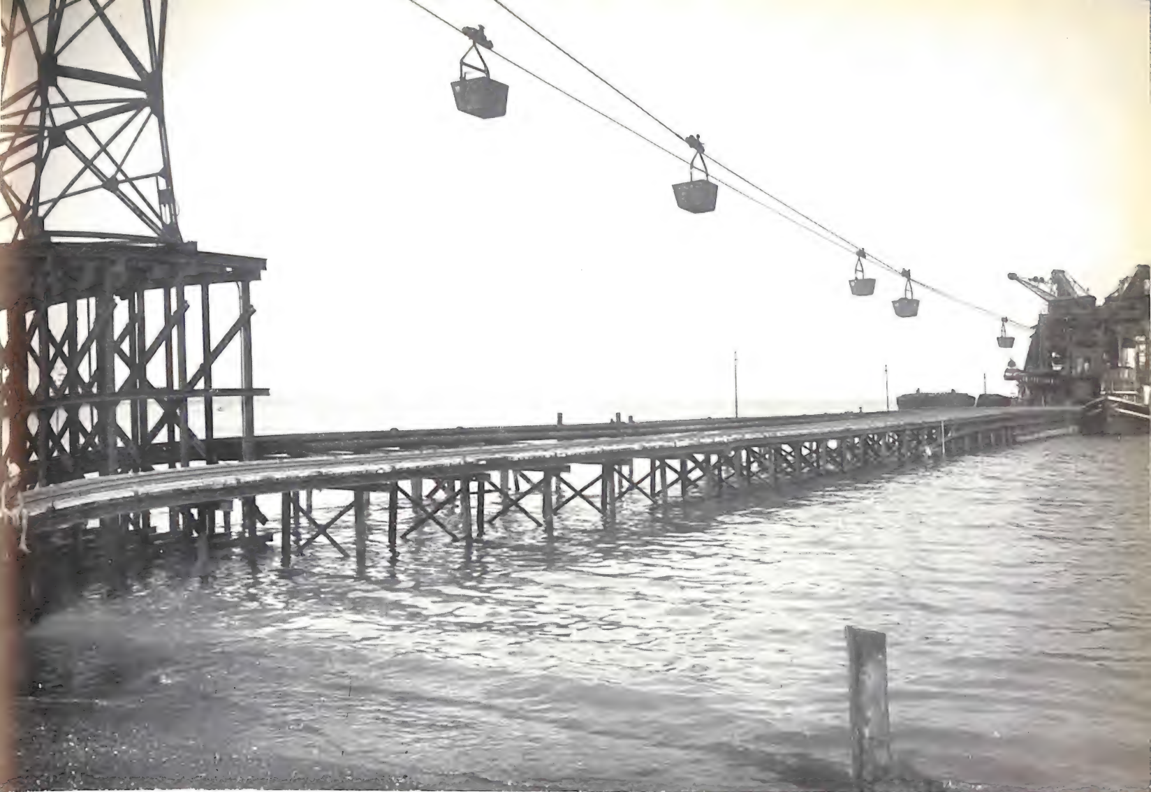
Vado Ligure - Pontile a mare - Stazione di testa della teleferica Società Carboni Fossili.
